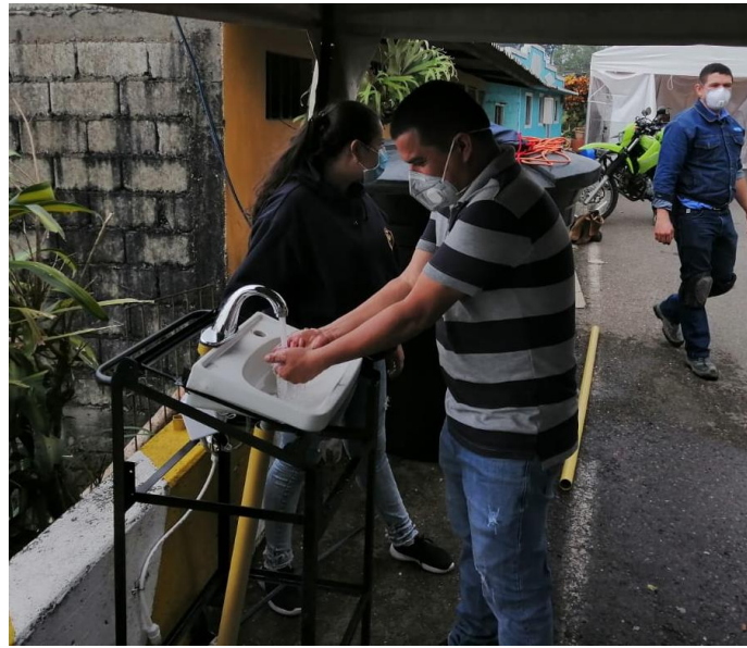
Instalación de Lavamanos Portátil Samaná
