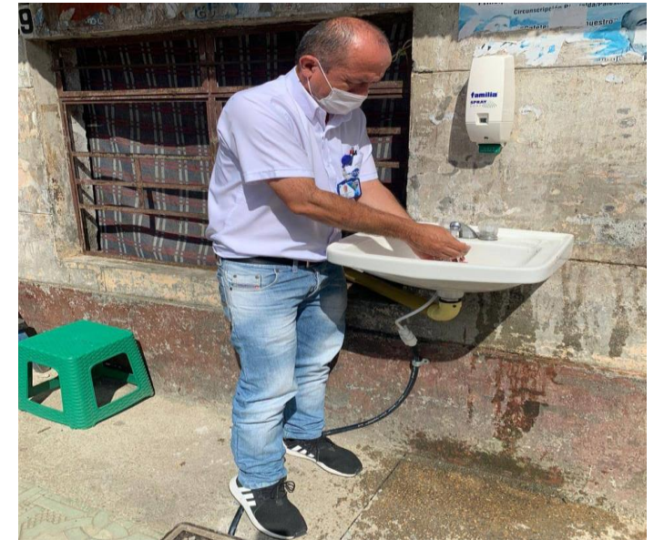
Instalación de Lavamanos Portátil Risaralda
